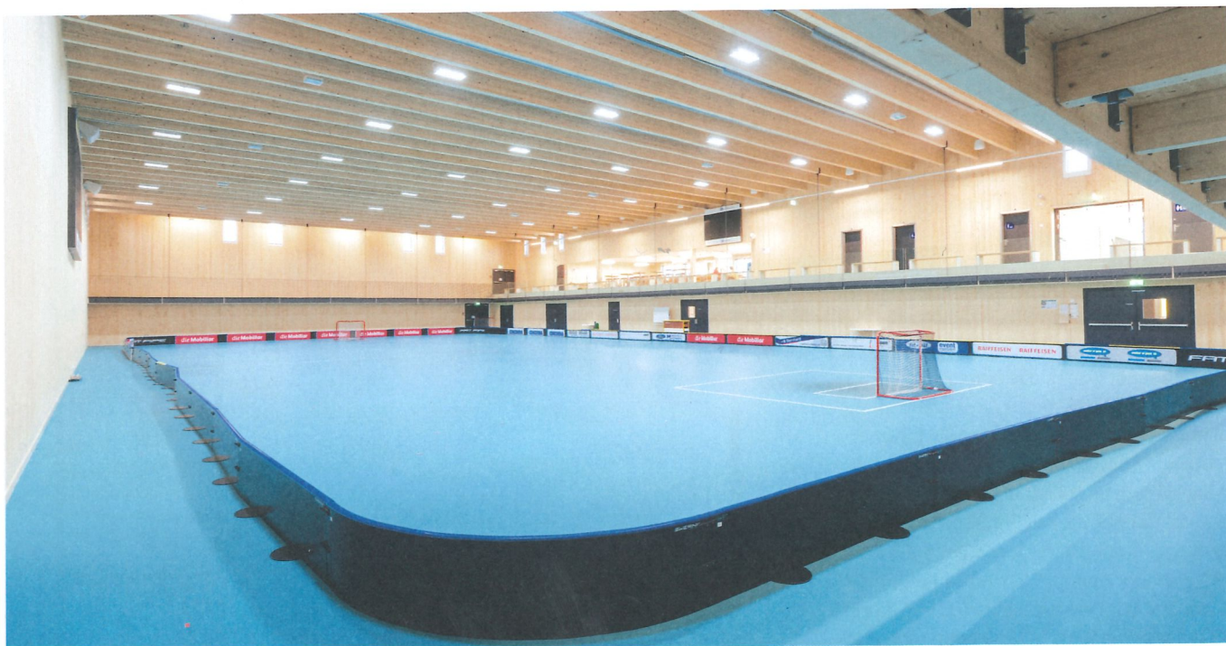
35 Brettschichtholzträger überspannen mit ihren knapp 28 Metern die Turnhalle. Von der dreiseitigen Galerie im Obergeschoss können bis zu 300 Zuschauer ihren Teams zujubeln.
