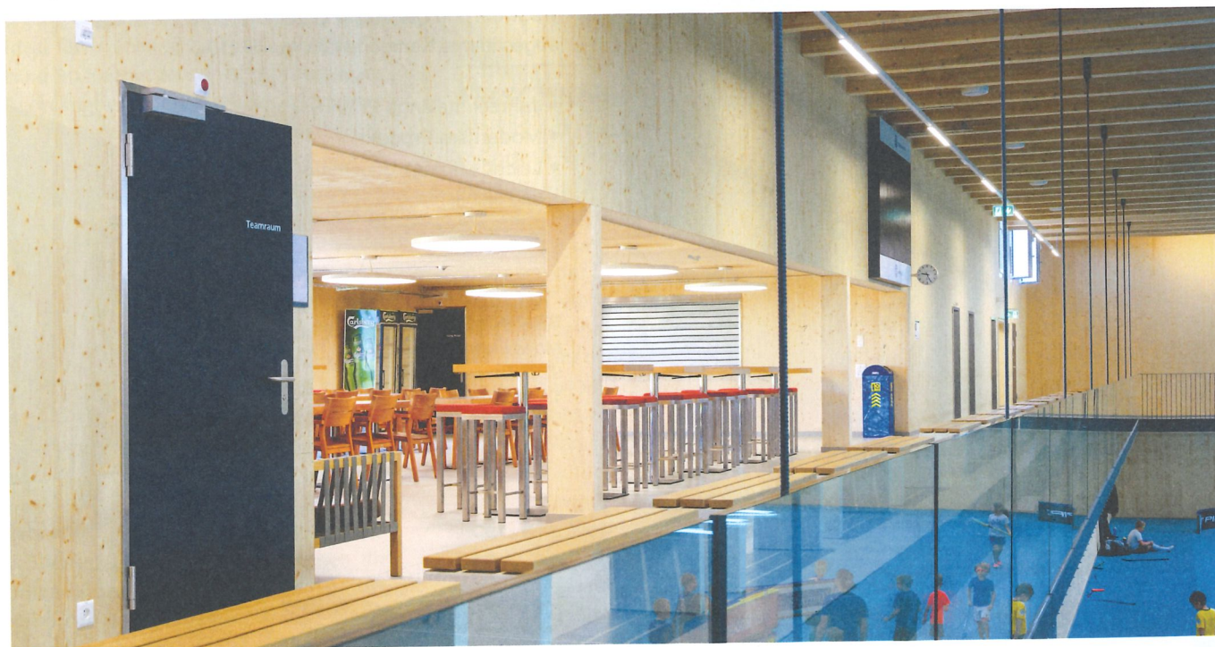
Endlich wieder Platz zum Trainieren: In Klotten freuen sich auch die kleinen Sportler über die neue Heja Sporthalle Stighag. Im Obergeschoss ist eine Cafeteria untergebracht.
