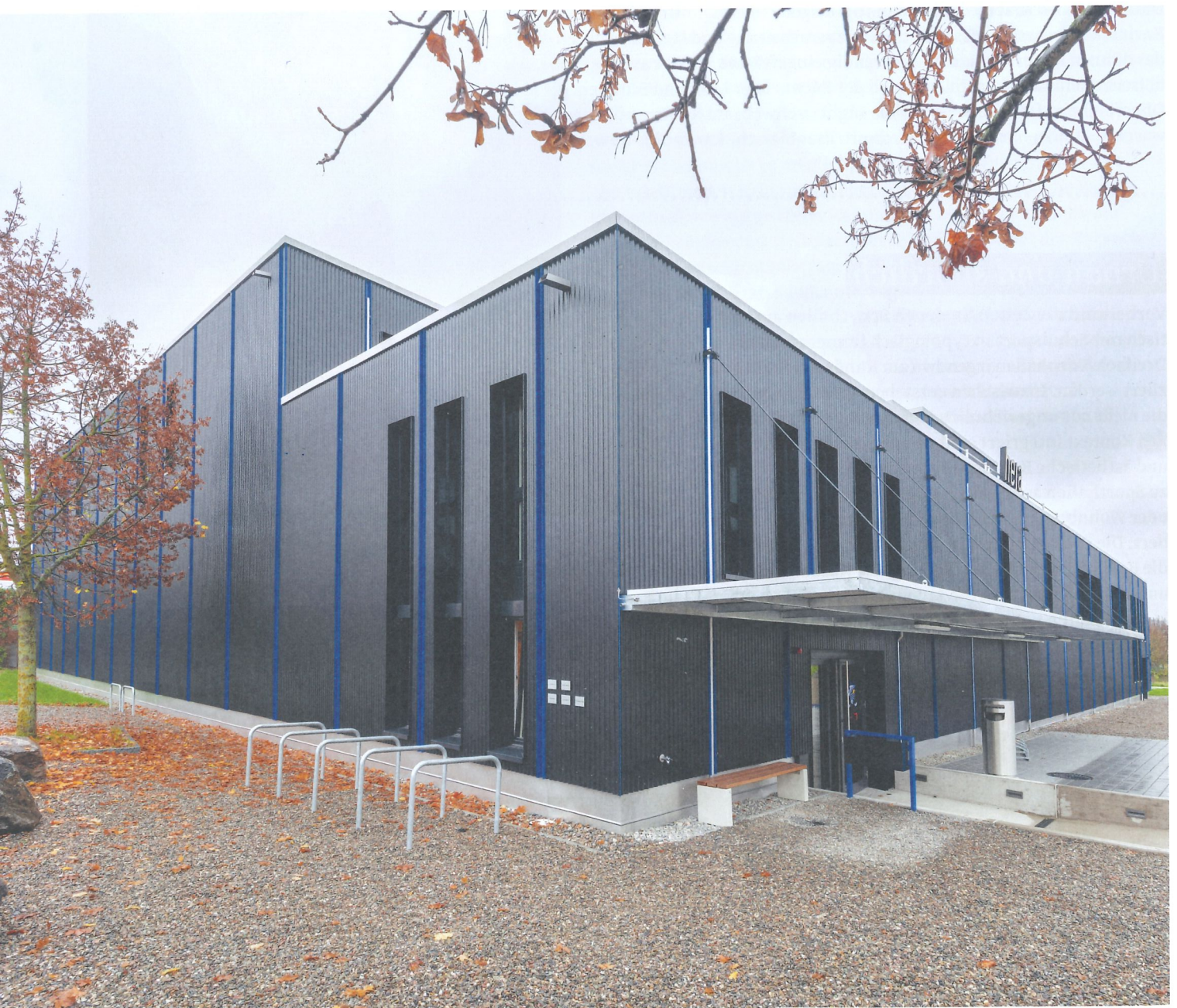
Markante Fassade: Die Wellblechverkleidung wird durch vertikale blaue Linien akzentuiert.
